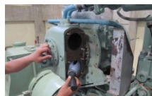
過給器取外作業
