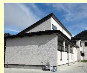
平成 30 年完成の学生寮 （神津島村提供）
