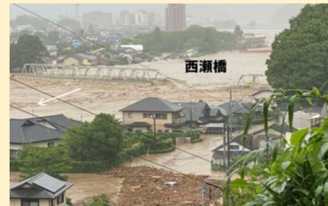
球磨川における西瀬橋の流出
