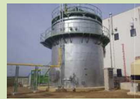
下水道施設におけるバイオマスメタン発酵事業
