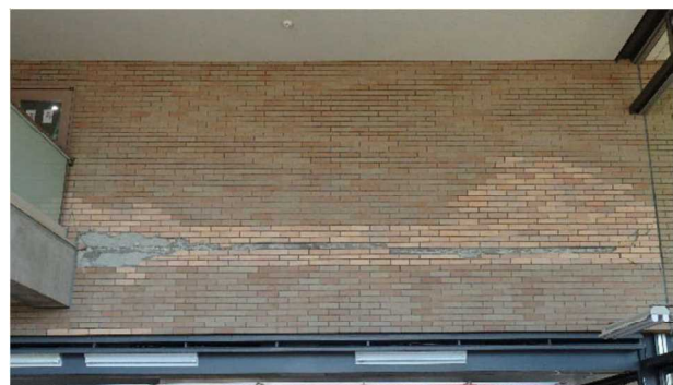
南側吹き抜け部における壁脚部の損傷
