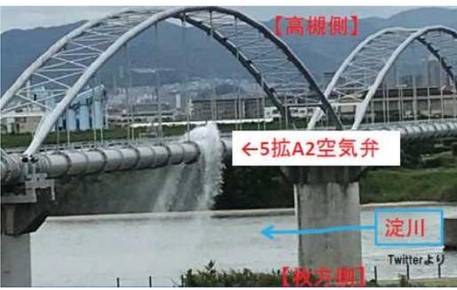
(空気弁: 管路内の空気を自動的に排气又は管路内へ吸気する装置)
