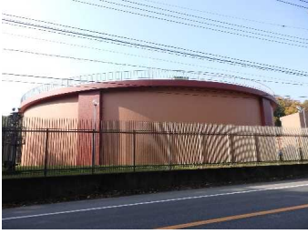
中里中継ポンプ場（調整池）
