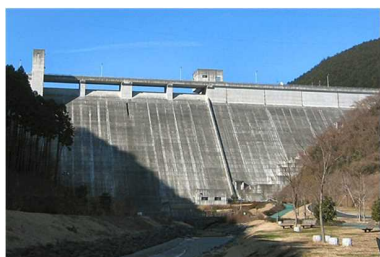
松田川ダム(栃木県) H7事業完了
