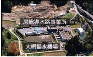
大網揚水機場
