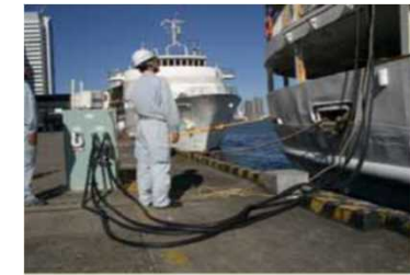
船舶への陸上電力供給
