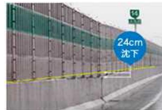
橋桁の中央付近が設計時の想定よりも大きく沈下
