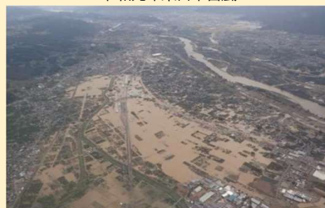
千曲川における浸水被害状況
