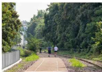
廃線の緑化(フランス) 廃線後も線路は残し、周囲を再整備することで、レクリエーションや生態系観察の場として市民に利用されているほか、治安向上の効果もある。
