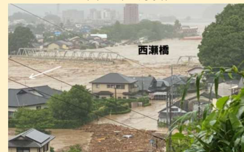
球磨川における西瀬橋の流出
