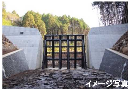
○砂防堰堤の整備
