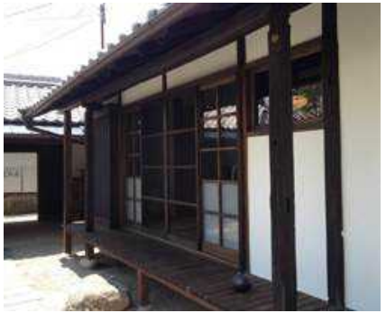
古民家を宿泊施設に改装して運営 (明日香村おもてなしファンド)
