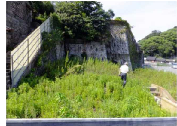
雑木が繁茂している例（イメージ） （出典）国土交通省「空き地等の新たな活用に関する検討会」資料
