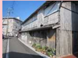
空き家の除却
