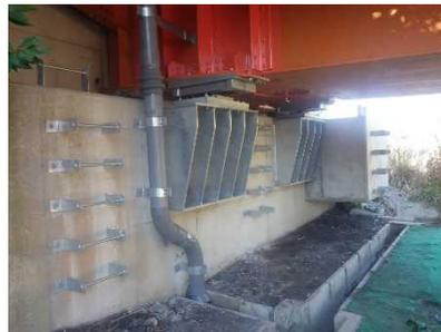
支承補強(水平力分担構造)
