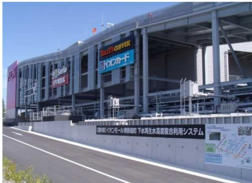
熱源利用する大型商業施設
