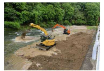
フラッシュ放流・土砂還元 の状況
