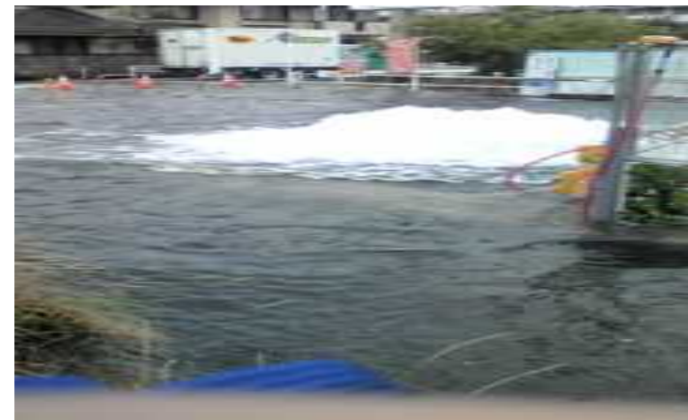
管路破裂事故の状況
