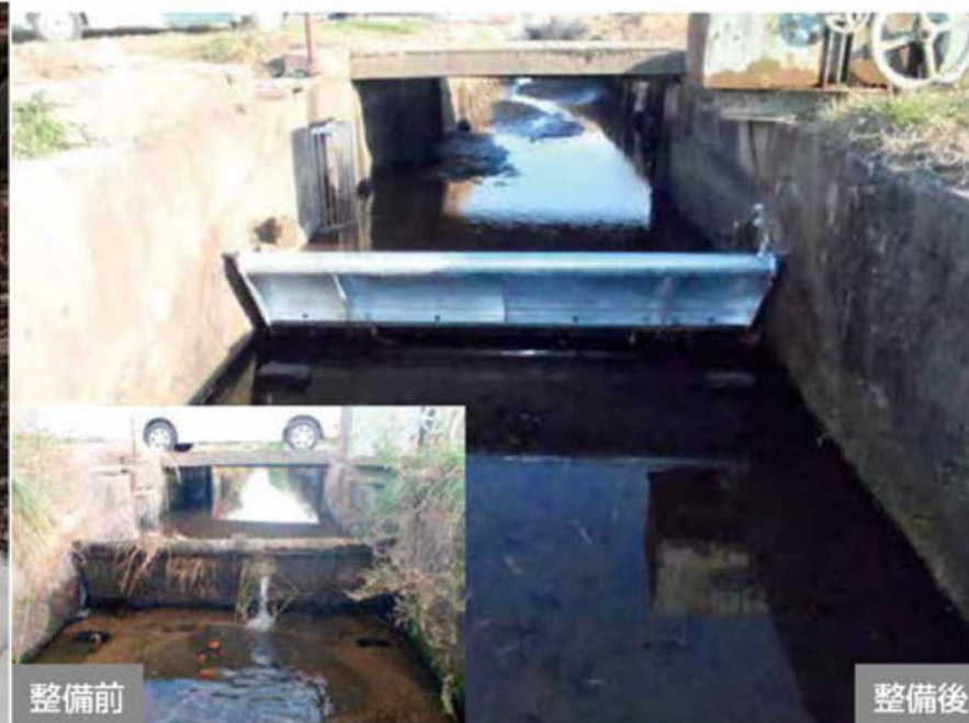
取水ゲートの更新
