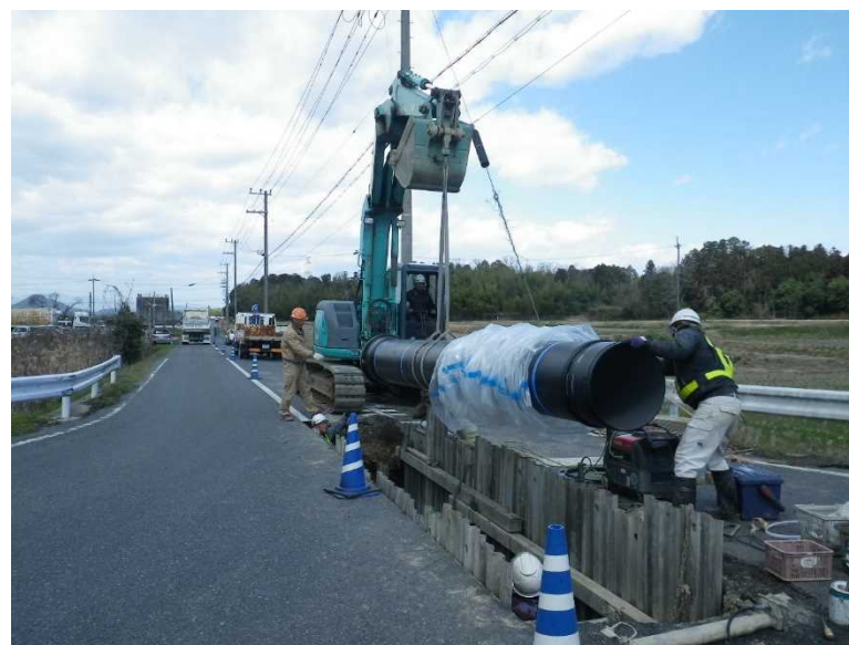
管路の更新作業の様子
