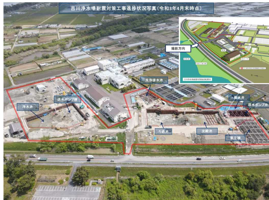
吉川浄水場耐震工事実施状況
