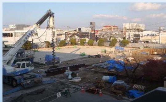
ポンプ場耐震工事
