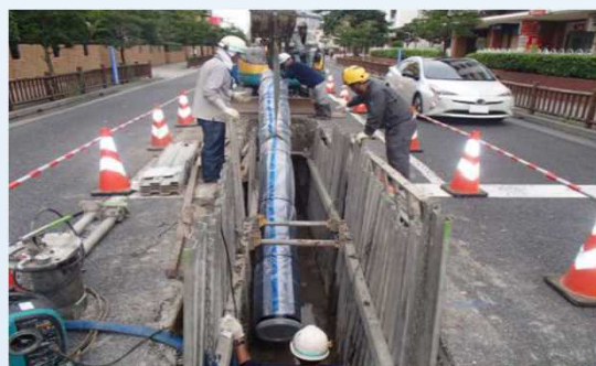
配水管更新工事
