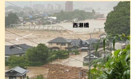
球磨川における西瀬橋の流出
