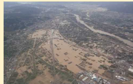
千曲川における浸水被害状況
