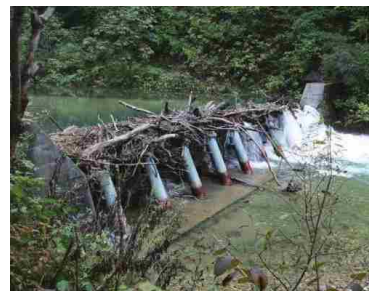
流木捕捉機能を持った治山ダム
