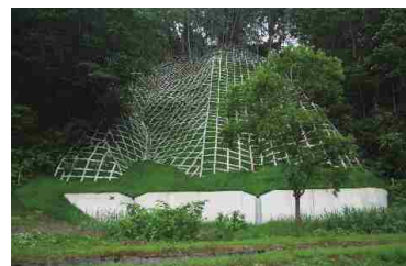
斜面の安定を図る山腹工
