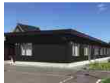
道産材を活用した道営住宅(余市町)
