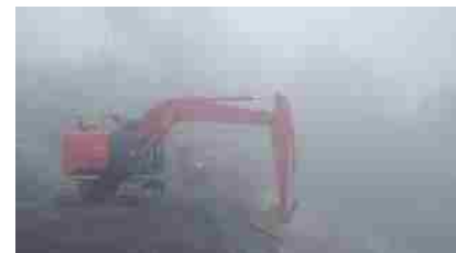
濃霧条件下でのICT施工状況
