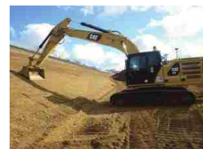
道路の新設工事におけるICT建設機械での切土法面の掘削状況
