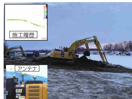
施工履歴を用いたICT施工
