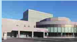
防災設備の改修（中標津町）
