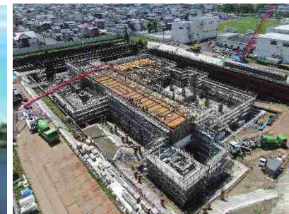
新浄水場施工状況 写真提供：釧路市
