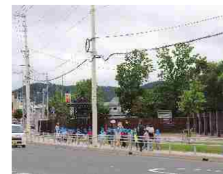
交通安全対策：防護柵
