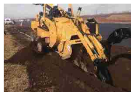
トレンチャー機械による掘削の試験施工 （寒地土木研究所 苫小牧寒地試験道路）
