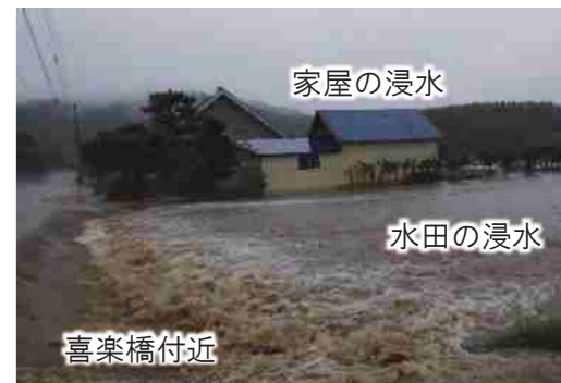
パーパン川（旭川市）の浸水被害状況 （平成30年7月）
