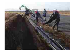
角型多条電線管の試験施工 （寒地土木研究所 苫小牧寒地試験道路）
