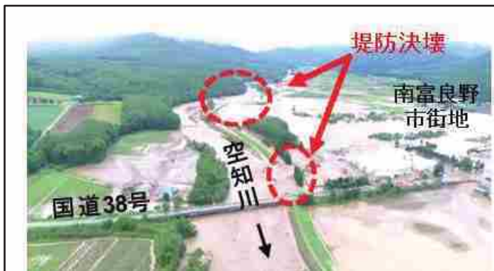
空知川の被災状況
