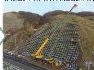
【国道232号 苫前町力屋地区法面対策】
