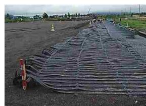
軟弱地盤上の盛土を補強するためのグラベル基礎補強工法
