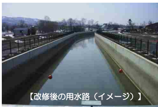
【用水路の改修状況】
