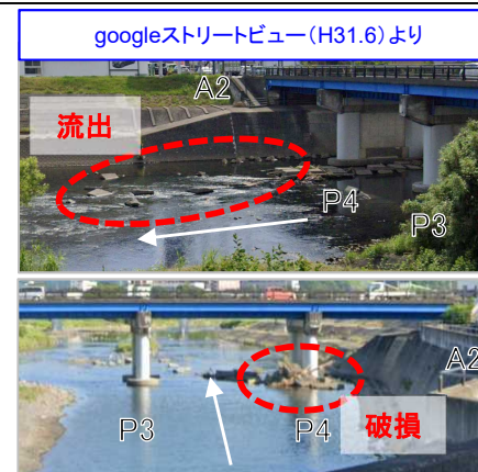
護床工の破損・流出(定期点検前)
