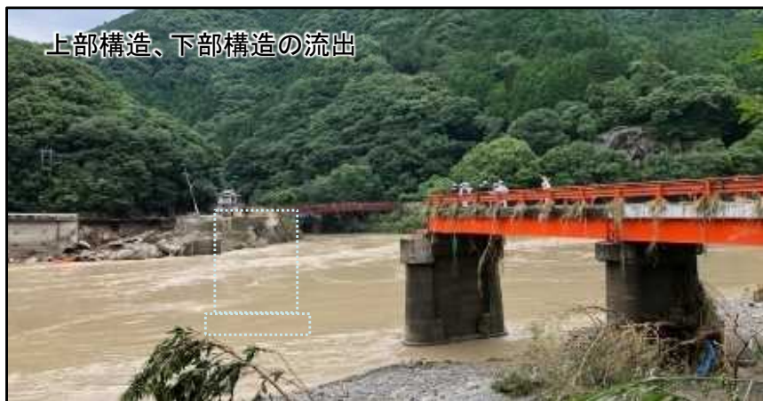
<熊本県 一般県道小鶴原女木線 深水橋>
