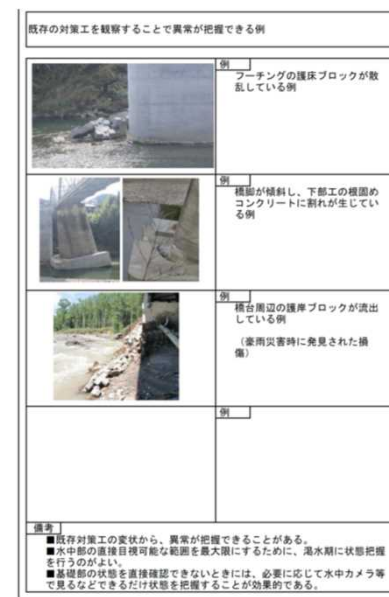
護床工の破損・流出(定期点検前)
