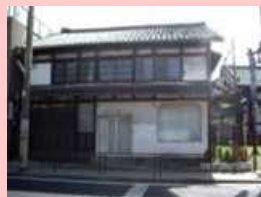
空き家の活用
