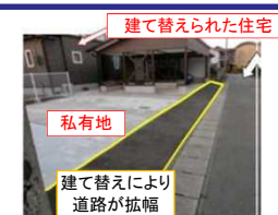
狭隘道路の解消となった例
