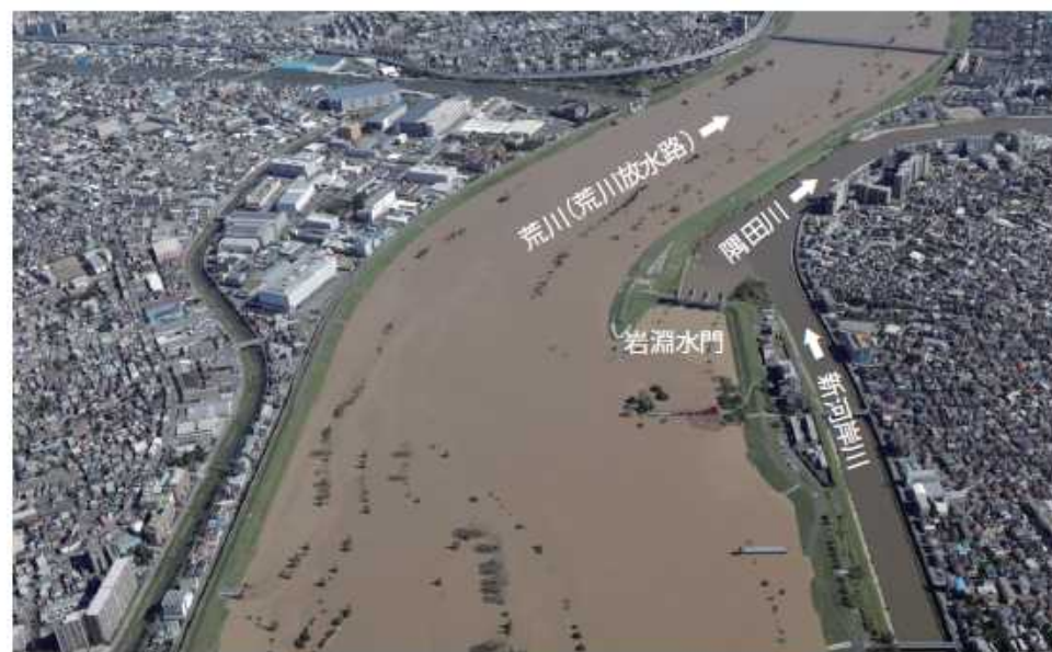
東京都北区岩淵水門付近 (2019年10月13日13時頃撮影)
