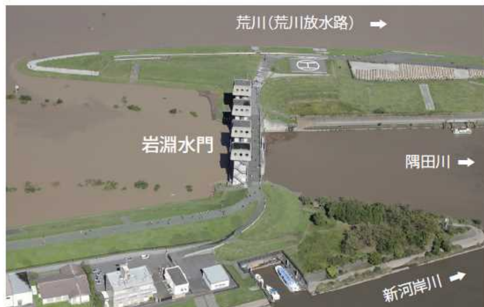
荒川と隅田川の水位差状況
