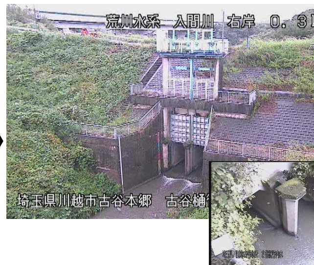
CCTVによる安全確認
