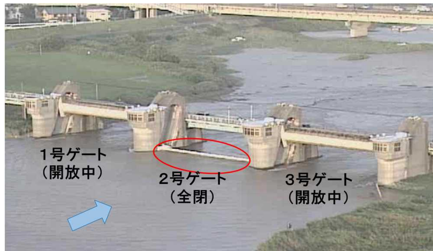
平成19年台風9号時の堰中央2号ゲートの操作不能状況
