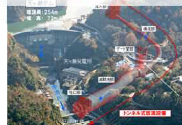
天ヶ瀬ダム(国土交通省)S39完成 天ヶ瀬ダム再開発(国土交通省) R3完成予定
