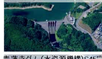
青蓮寺ダム(水資源機構)S45完成
