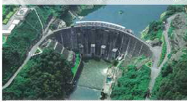
比奈知ダム(水資源機構)H10完成
