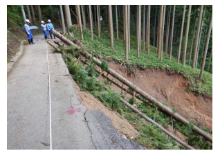
法面崩壊状況調査(京都府)
