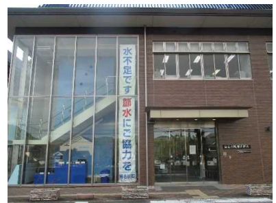
節水啓発の垂幕を設置(兵庫県猪名川町) 出典: 兵庫県より提供
