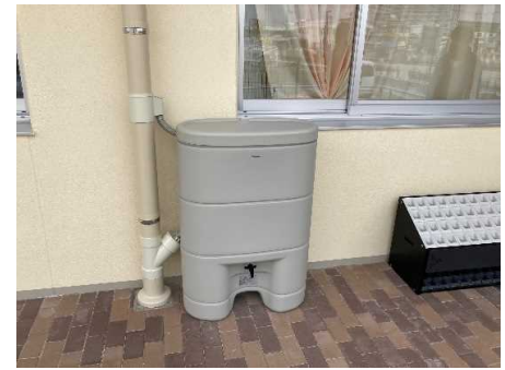
雨水貯留タンクの設置状況
