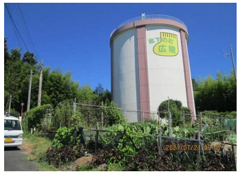
大野配水場 出典: 奈良県より提供
