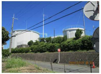
真美ヶ丘配水場
