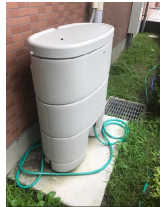
雨水貯留タンクの設置状況
