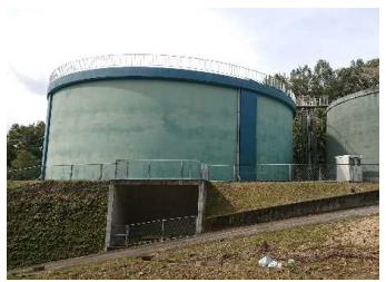
恩ヶ芝配水池
