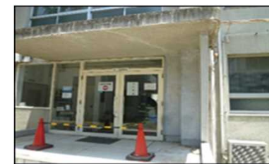
第一実習実験棟
