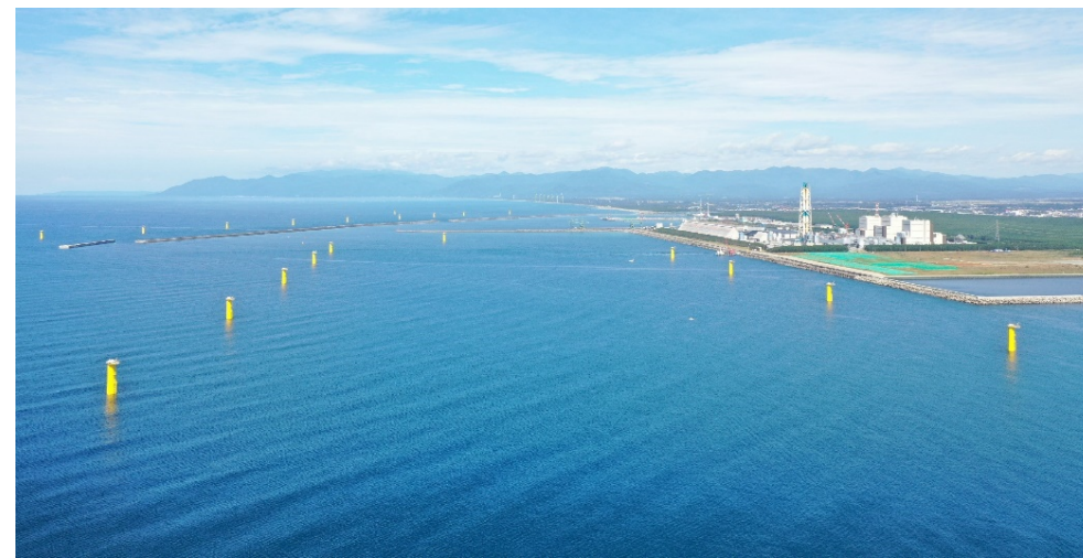
能代港内の基礎工事完了
