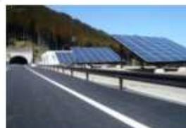
道路における太陽光発電施設活用
