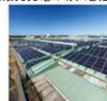
下水処理場の上部空間を活用した太陽光発電
