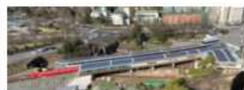
東京メトロ提供 丸ノ内線四ツ谷駅
