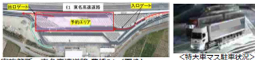
実施箇所：東名高速道路 豊橋PA（下り） （無料実験としてH31年4月より開始、R3年5月より深夜時間帯を一部有料化）
