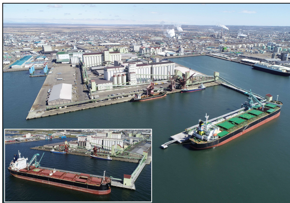
釧路港国際物流ターミナル(平成31年3月供用開始)
