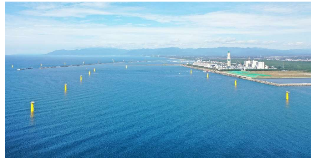
能代港内の基礎工事完了
