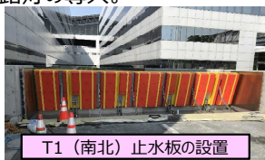
T1(南北)止水板の設置
