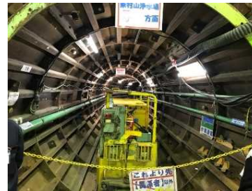
<第二原水連絡管内部 (東村山浄水場方面)>
