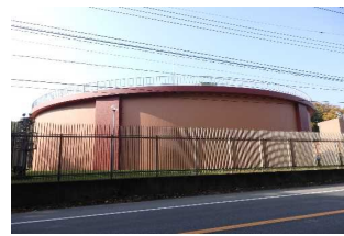
中里中継ポンプ場(調整池)
