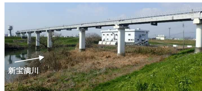
思案橋水管橋
