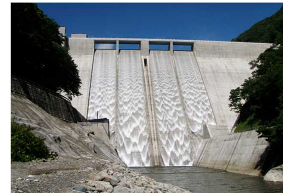
湯西川ダム(国土交通省) H23事業完了
