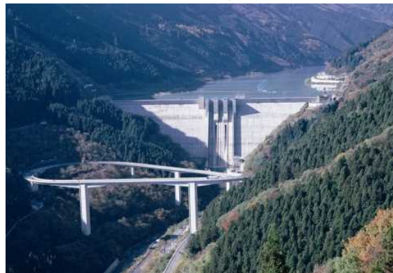
滝沢ダム(水資源機構) H22事業完了
