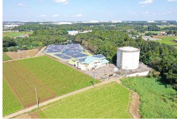
北総中央土地改良事業造成施設(農林水産省) R2事業完了予定
