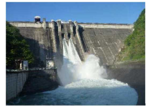
水質事故時における下久保ダムから下流河川への放流増の様子(H24.5.17)
