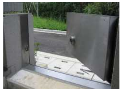
<整備例> 防水扉(金町浄水場)
