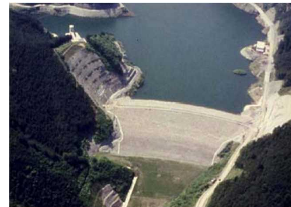
有間ダム(埼玉県) S60事業完了
