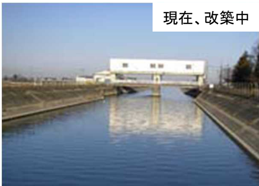
埼玉合口二期施設(水資源機構) H6事業完了
