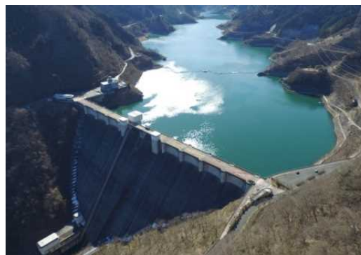
浦山ダム(水資源機構) H18事業完了
