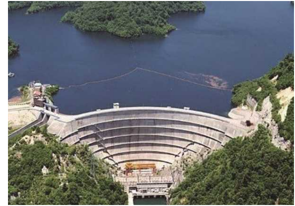
利根大堰(水資源機構) S42事業完了 H9改築
