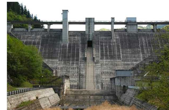
合角ダム(埼玉県) H14事業完了
