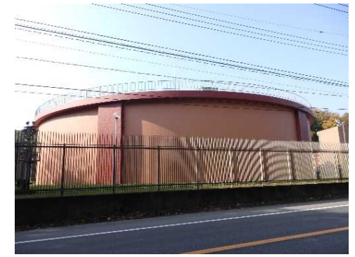
中里中継ポンプ場(調整池)
