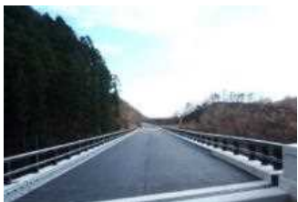
付替県道工事
