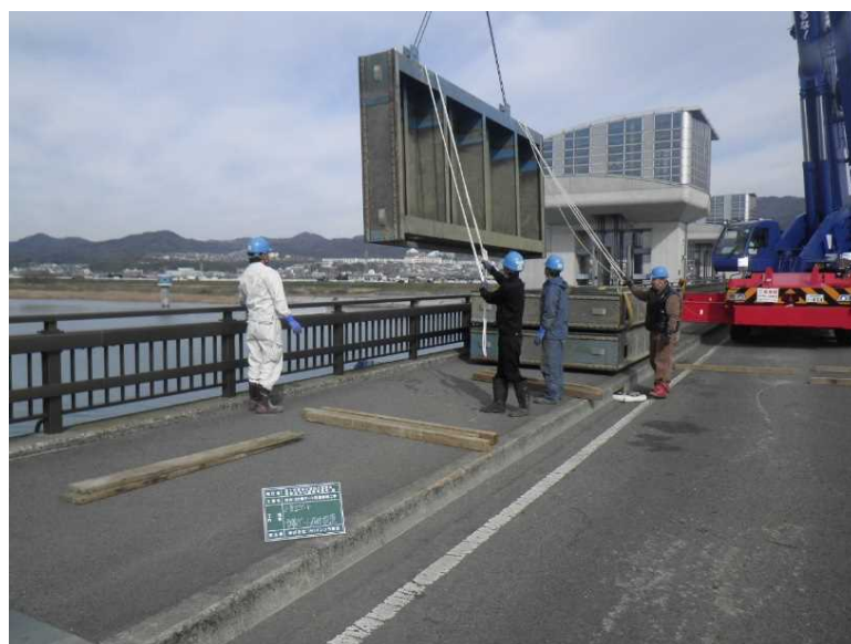
③予備ゲート設置(吊込)
