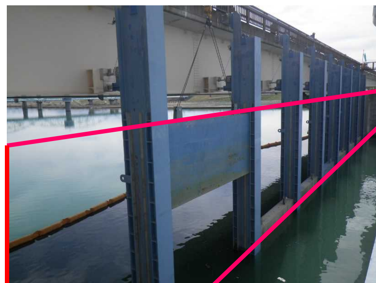
④予備ゲート設置
