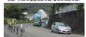
図9 国道56号の急カーブ箇所
