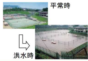
貯留施設の整備
