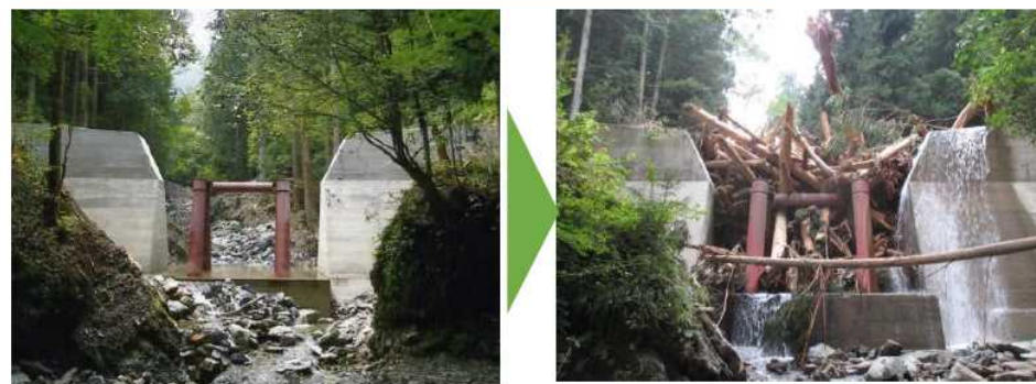
流木捕捉式治山ダムの整備による流木等の捕捉
