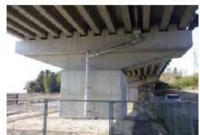
緊急輸送道路上の橋梁の耐震化
