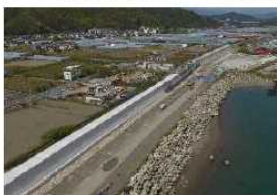
河川堤防・海岸堤防等の整備
