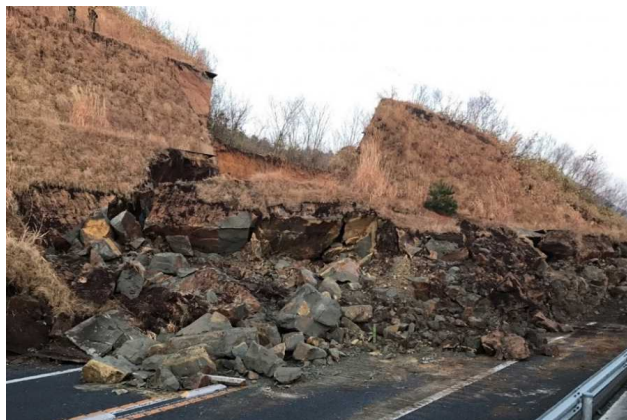
被災場所: 常磐道(相馬IC~新地IC):切土部 発生日時: 令和3年(2021年)2月13日 23時7分 ※福島県沖地震
