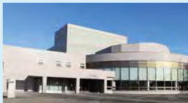
防災設備の改修(中標津町)
