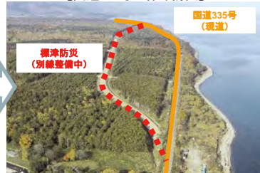
【国道335号 標津防災】
