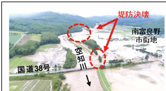
空知川の被災状況
