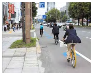
自転車の通行位置を示す矢羽根型路面表示の設置例 一般国道230号(札幌市)
