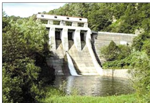
雨竜川ダム再生事業（雨竜第二ダム（幌加内町）） （堤体かさ上げ・容量振替予定）
