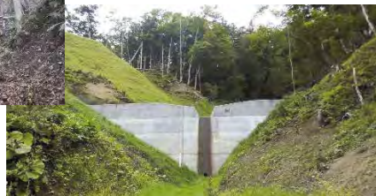
治山ダム設置、危険木除去等による対策
