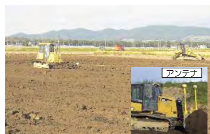
GNSSを活用した整地工の状況
