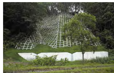
斜面の安定を図る山腹工
