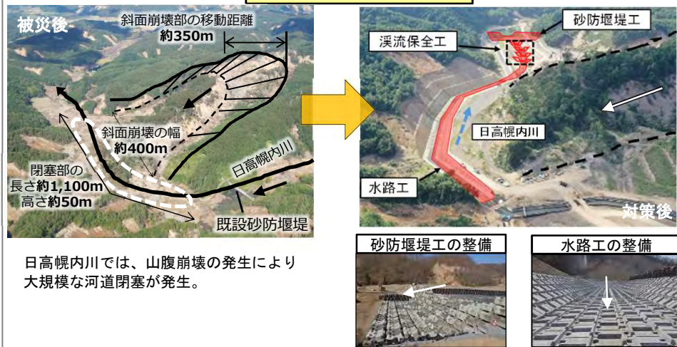
日高幌内川における対策工
