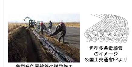
角型多条電線管の試験施工 (寒地土木研究所 苫小牧寒地試験道路) ※国土交通省HPより
