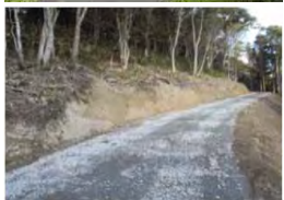
10t積み程度のトラックの走行を想定した「林業専用道」
