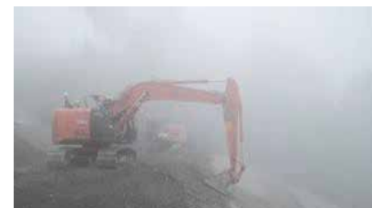
濃霧条件下でのICT施工状況
