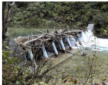
流木捕捉機能を持った治山ダム
