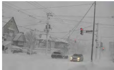
暴風雪による電線の破断 (網走市 国道244号)
