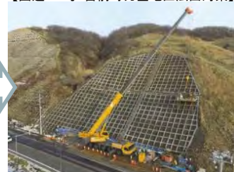
【国道232号 苫前町力屋地区法面对策】
