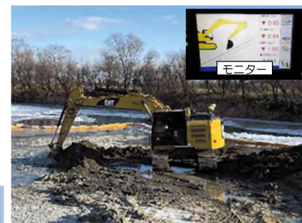
ICT建設機械による掘削作業の状況
