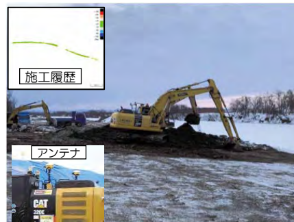
施工履歴を用いたICT施工
