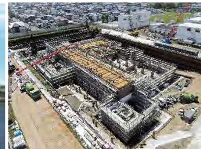
新浄水場施工状況 写真提供：釧路市
