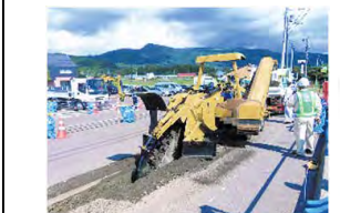
トレンチャー機械による掘削の試験施工 (国道5号 赤松街道電線共同溝)
