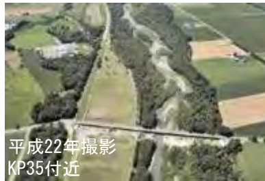
平成22年撮影 KP35付近 礫河原が僅かとなった札幌川
