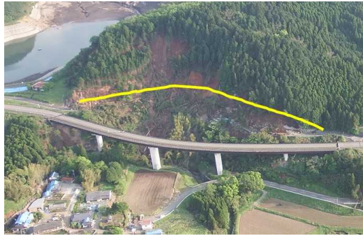
図-解 5.1.2 道路区域外からの危害により影響を受けなかった事例 (熊本県道熊本高森線 大切畑大橋)
