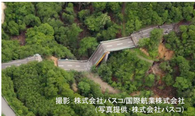
(a) 国道342号 祭時大橋
