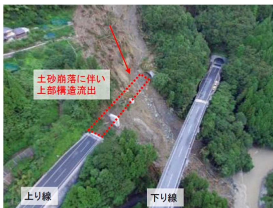
(a) 高知自動車道 立川橋
