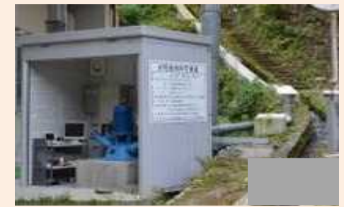
小水力発電設備
