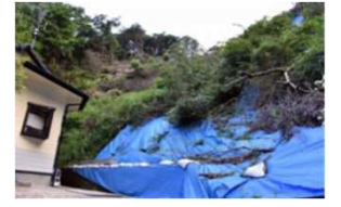
豪雨の度に土砂崩れが多発
