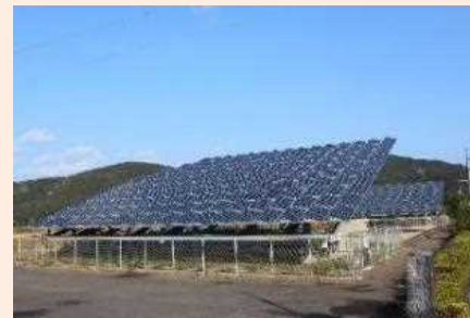
太陽光発電設備
