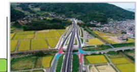
今福インターチェンジ付近
