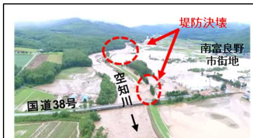
空知川の被災状況
