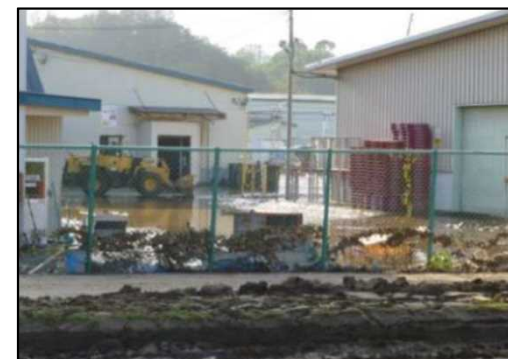
スイートコーン缶詰工場の被害状況
