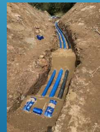
耐震管布設替工事の様子 （提供：小国町）
