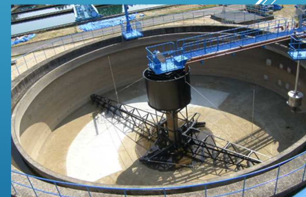
濃縮槽更新工事 （提供：熊本県企業局）
