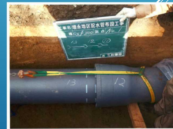
水道管耐震化工事の様子 （提供：荒尾市）
