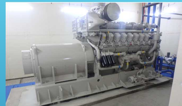
予備発電機更新工事 （提供：熊本県企業局）
