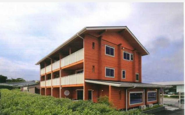
断熱性能向上等による高い階高の3階建て木造
