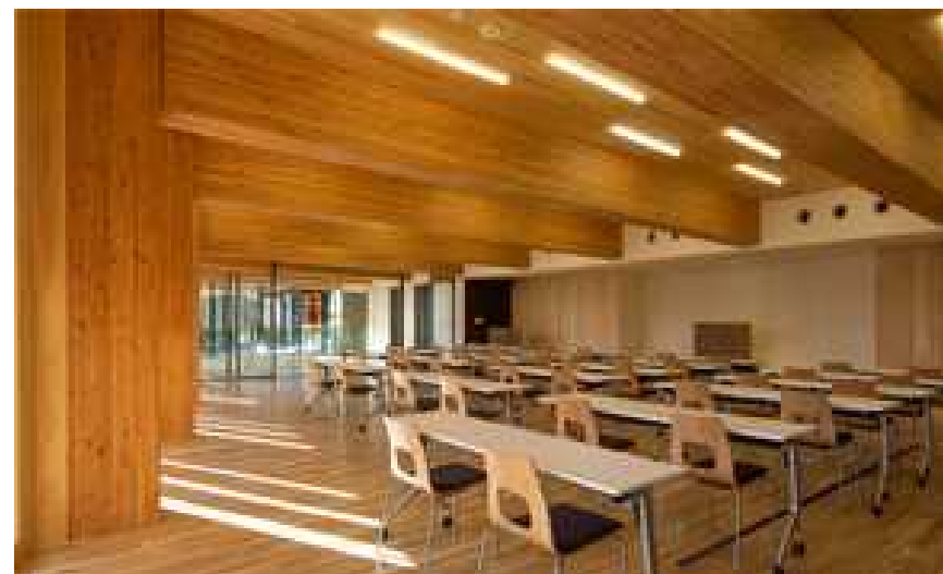
大阪木材仲買会館、木造・RC造等、最上階(3階)会議室、耐火構造、設計:竹中工務店
