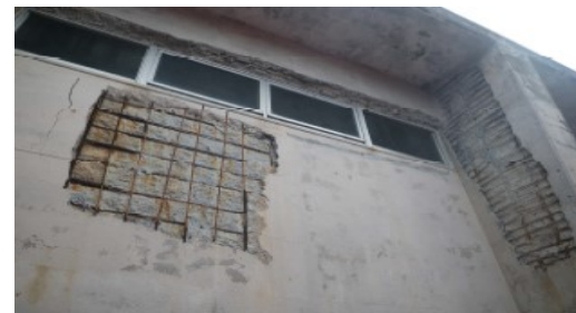
東北部・出入口周辺 (3号上屋)
