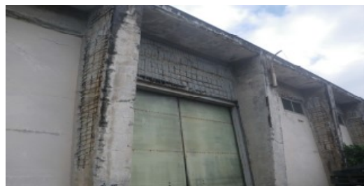
南東部・出入口周辺 (3号上屋)
