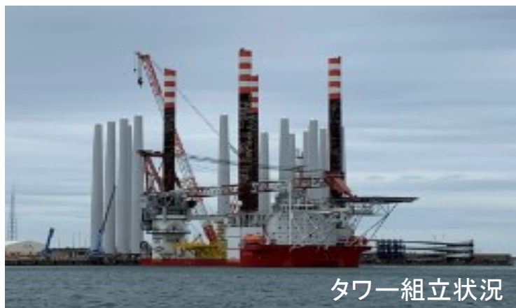
<秋田洋上風力発電(株)ホームページより>
