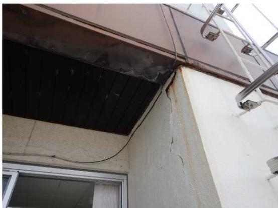
2F北面外壁: ひび割れが発生し内部が腐食している
