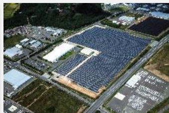
八戸太陽光発電所
