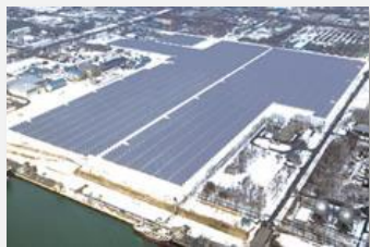
苫小牧太陽光発電所
