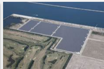
大分太陽光発電所
