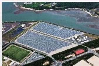
山陽小野田太陽光発電所
