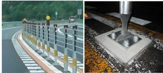
（中小橋の設置状況）
