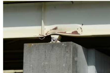
九州自動車道 木山川橋
