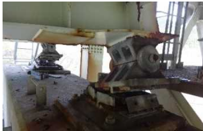
大分自動車道 並柳橋
