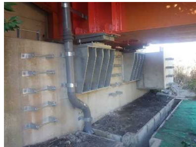
支承補強(水平力分担構造)
