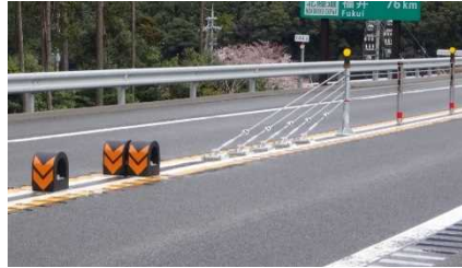
（土工部の設置状況）
